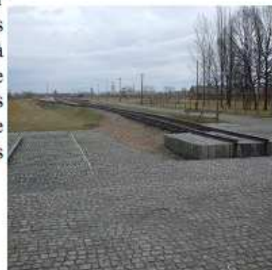
La rampe prolongée jusqu'à l'intérieur du camp
