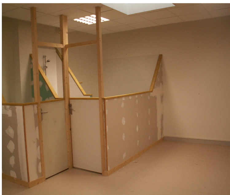
Espace Salle-d'eau + Wc Préparation et mise en peinture
